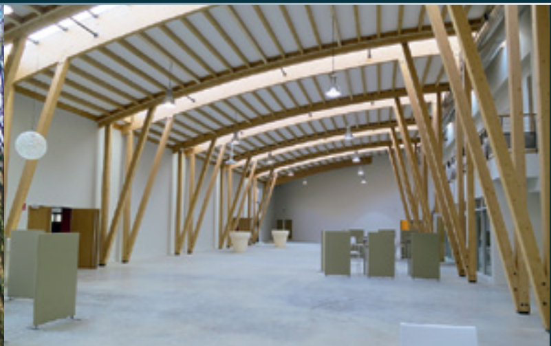
Atelier de maroquinerie - Lezoux Architecte : CABINET TWI
