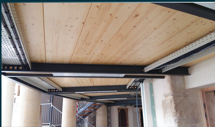
PLANCHER BOIS (VUE DE DESSOUS)
